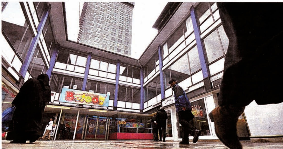
Die Walter-Passage zwischen Fußgängerzone und Hugenottenplatz könnte neu belebt werden. M. MÜLLER
